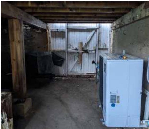
070057 : l'unité extérieure est installée sous un appentis dans une zone confinée. Un recyclage d'air important est mesuré sur cet équipement : la température mesurée par notre station météorologique placée à proximité de l'UE chute dès que la PAC se met en route.
